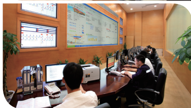
ECC控制中心
